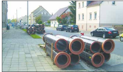
Kanalsanierungen werden durch den GWAZ stets gut vorbereitet.
