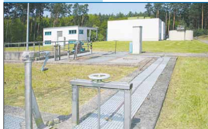
Die Kläranlage Trebatsch wurde 1994 gebaut. Die für insgesamt 8.500 Einwohnerwerte ausgelegte Anlage reinigt das häusliche Abwasser der Orte Trebatsch, Ranzig, Ressen, Jessern, Sawall, Zau, Guhlen, Goyatz und Lamsfeld zentral. Mobil werden die Orte Stremmen, Koszenblatt, Mittweide, Mochow, Briescht, Groß und Klein Liebitz und Siegelde entsorgt.
