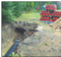
„Rohreinzug“ in Guben.
