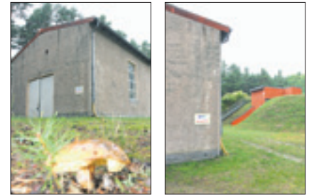
Das in den Jahren 1992/93 erbaute Wasserwerk Wellmitz versorgt heute rund 1.900 Menschen in den Orten Wellmitz, Ratzdorf, Breslack und Coschen der Gemeinde Neißemünde mit dem Lebensmittel Nummer Eins. Auf dem rechten Foto sehen Sie den Hochbehälter.
