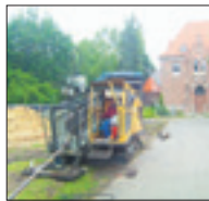
Arbeiten auf dem GWAZ-Areal.
