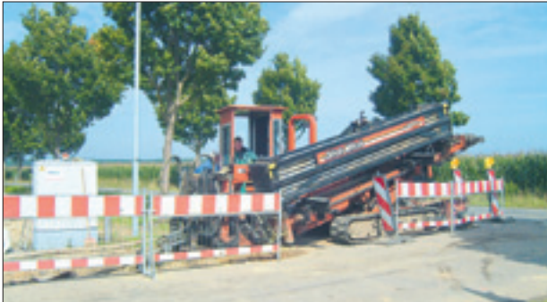
Das Spülbohrgerät der Firma MTS aus Demmin bei der Verlegung der Trinkwasserleitung in der Siedlung Groß Gastrose.
