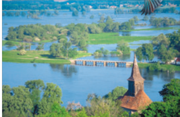
Frühjahrschloßwasser am Saathener Wehr an der Oder mit den gefluteten Poldern A und B. Das in den Jahren 1906 bis 1928 nach holländischem Vorbild errichtete Poldersystem bestimmt bis heute das Geschehen in der Aue. Die Flutungspolder können bis zu 130 Mio. m 3 Wasser aufnehmen.
