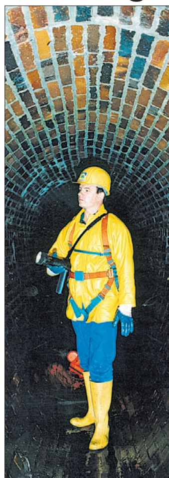
Besonders große Kanäle können auch heute noch von den Mitarbeitern direkt inspiziert werden. Bei kleineren Kanälen hilft das sogenannte Kanal-TV.
