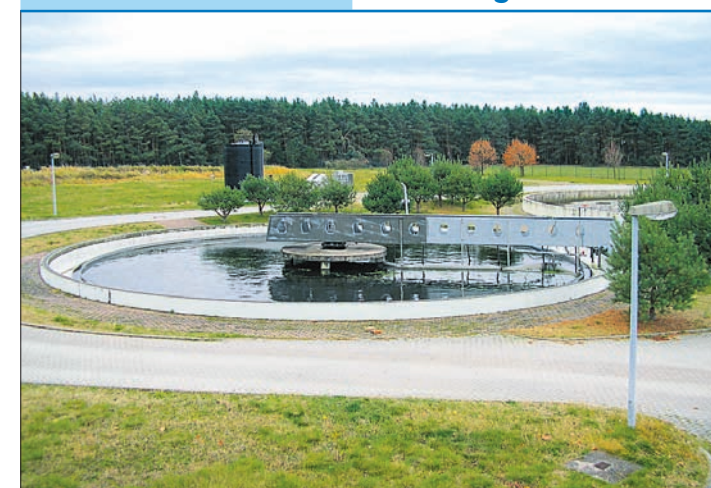
Die Kläranlage Friedland wurde von 1993–1994 gebaut. Die für insgesamt 7.500 Einwohnerwerte ausgelegte Anlage reinigt unter anderem das häusliche Abwasser der Orte Friedland sowie der Ortsteile Lieberose, Jamlitz, Staakow und Grunow.
