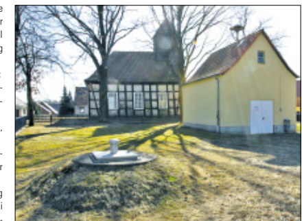
Das Wasserwerk (WW) Klein Muckrow wurde in den 1950er Jahren gebaut. Es versorgt die Orte Leeskow, Trebitz, Ullersdorf und Klein Muckrow – insgesamt rund 200 Kunden. Das Wasser aus Klein Muckrow ist nach Waschmittelgesetz im Härtebereich „mittel“ eingestuft.
