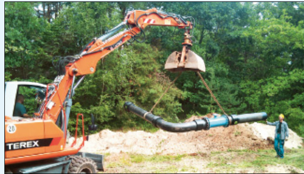
Eine der großen Maßnahmen im laufenden Jahr war der Bau der Trinkwasserüberleitung von Guben nach Taubendorf.
