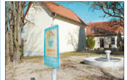
Das Wasserwerk (WW) Groß Muckrow wurde 1953 gebaut und 1999 teilsaniert. Neben Groß Muckrow versorgt es noch den Ort Chossewitz. Das Lebenselixier kommt aus diesem Werk mit mittlerer Härte.
