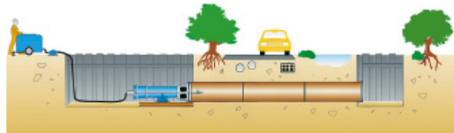
Beim dynamischen Rammverfahren sind Umleitungen oder auch halbseitige Straßensperrungen unnötig.
