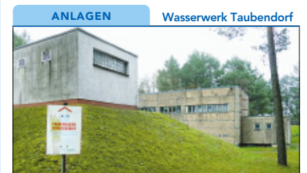
Das Wasserwerk Taubendorf existiert seit 1977. Damals wurden zwei Reinwasserbehälter in Betrieb genommen. Im Jahr 1994 modernisierte der GWAZ die Anlage, um die Einwohner von Grieben und Horno mit dem Lebensmittel Nummer 1 zu beliefern. Aufgrund des Braunkohle Tagebaus wurde 2005 die Versorgung von Horno eingestellt. Das Wasserwerk besitzt drei Brunnen, die das Rohwasser aus einer Tiefe zwischen 50 und 65 m ans Tageslicht fördern. Jährlich werden von hier rund 40.000 m 3 Trinkwasser ins Versorgungsnetz eingespeist. Das Werk soll 2012 in Rente geschickt werden.
