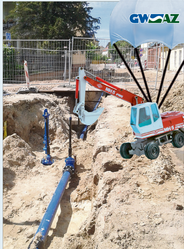
Schwere Bagger mussten bei dieser Maßnahme gar nicht mehr „einfliegen“ – das Foto zeigt den Bauabschnitt in der Alten Poststraße. Hier werden Trinkwasserhauptleitungen und Hausanschlüsse erneuert.
