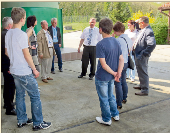
Frühere und aktuelle Partner des GWAZ nutzen die Gelegenheit, sich die Abwasserbehandlungsanlage in Gubin genauer anzusehen. GWAZ-Chef Wolfram Nelk (Mitte hinten) führte über die Anlage.
