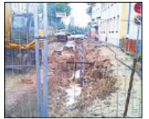
Dauerregen erschweren die Arbeiten in der Alten Poststraße.
