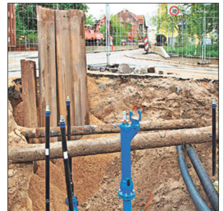
Im Rahmen der Straßensanierung in Guben im Bereich Alte Poststraße und Uferstraße hat der GWAZ auf einer Strecke von 700 Metern die Trinkwasserleitungen komplett ausgetauscht und die Hausanschlüsse gewechselt. Die alten Leitungen hatten sage und schreibe 120 Jahre auf dem Buckel.
