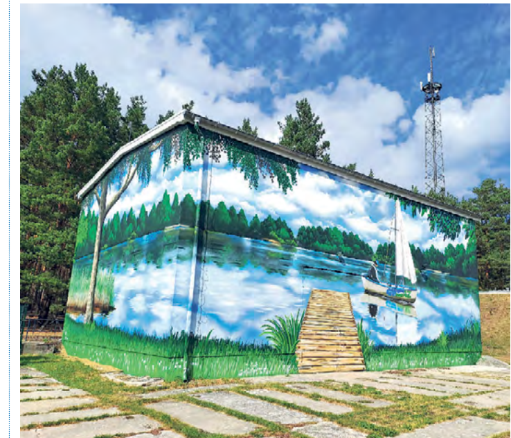
Das Graffiti zeigt die seenreiche Umgebung. Doch das Wasserwerk Lamsfeld ist nicht nur hübsch anzusehen.
