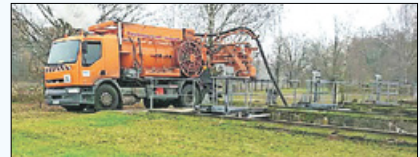
Das Saugspülfahrzeug des GWAZ ist täglich im Einsatz – hier beim Reinigen der Speicherbecken. Foto: GWAZ
