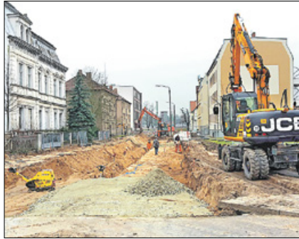
Auch im vergangenen Jahr hat der GWAZ seine Anlagen und Netze ausgebaut bzw. erneuert. Eine umfangreiche Baumaßnahme war die Kanalsanierung in der Alten Poststraße in Guben. Foto: GWAZ
