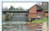
Das Überfallwehr des Spree-Dahme-Umlutkanals in Märkisch Buchholz. Das Wasser fällt vier Kaskaden hinunter und „überwindet“ fünfzehn Meter Höhenunterschied.
