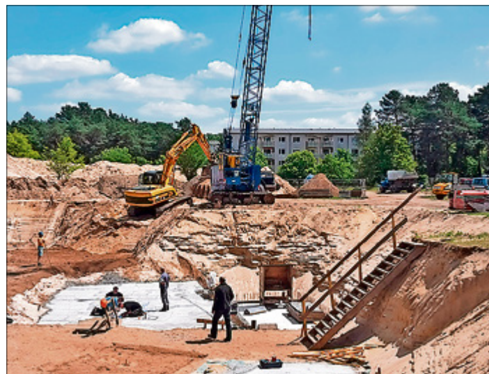
Die Arbeiten an der Druckerhöhungsstation. Foto: S. Buckel-Ehrlichmann
