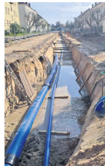
Verlegung von Trinkwasserleitungen in Guben, Friedrich-Engels-Straße. Fotos (2): GWAZ
