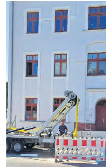
Pestalozzistraße in Guben: Einzug des Schlauchliners in den zu sanierenden Mischwasserkanal.
