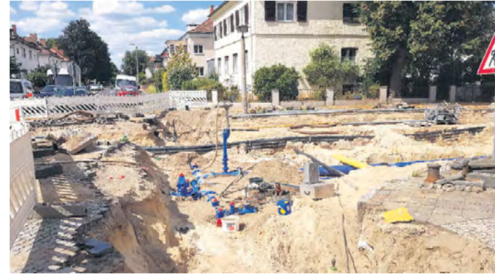
Fortsetzung erfolgt in diesem Jahr: Die Verlegungen der Trink- und Abwasserleitungen in Guben, Friedrich-Engels-Straße (Gemeinschaftsbaumaßnahme Stadt Guben und GWAZ). Fotos (2): GWAZ
