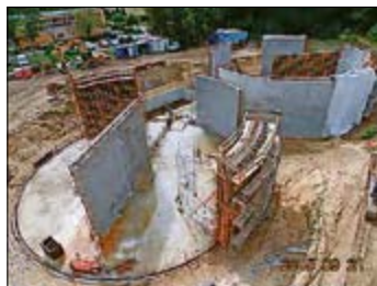
Es geht voran. Mitte September waren erste Betonwände gegossen.
