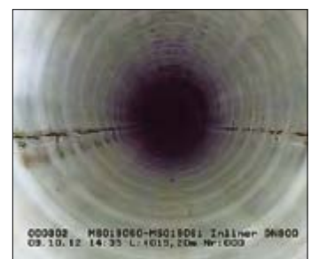
Nachher: Blitzblank sieht der Kanal nach der Reinigung aus. Wurzeln und Ablagerungen sind beseitigt.
