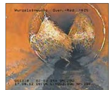
Vorher: Die Kamerabefahrung bringt es ans Licht – in diesem Kanal sind bereits Wurzeln eingewachsen.
