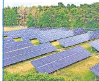
Die neue Photovoltaikanlage sorgt für grünen Strom auf und für die Kläranlage Guben/Gubin. Foto: POS Guben-Guben
