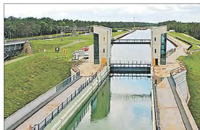
Die 65,50 m lange Kanalbrücke verbindet das Schiffshebewerk mit dem oberen Vorhafen. Sie bietet wie der Hebewerkstrog eine nutzbare Wasserspiegelbreite von 12,50 m. Das Sicherheitstor bildet das östliche Ende der Scheitelhaltung des Oder-Havel-Kanals. Rechts und links erhält die Brücke Seitenwege, die befahren werden können.
