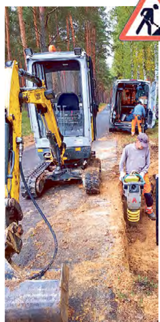
Die Trinkwassererschließung in Klein Liebitz wurde im Juni erfolgreich beendet. Damit ist die Versorgung der Anwohner gesichert. Foto: GWAZ
