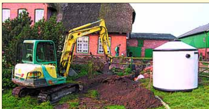
Aushub einer Grube für eine Kleinkläranlage. Bei richtiger Funktionsweise machen Flora und Fauna Freudensprünge.
