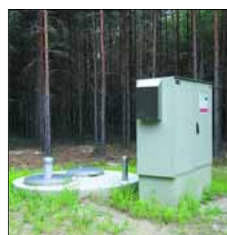
Die Brunnenfassung in Atterwasch.
