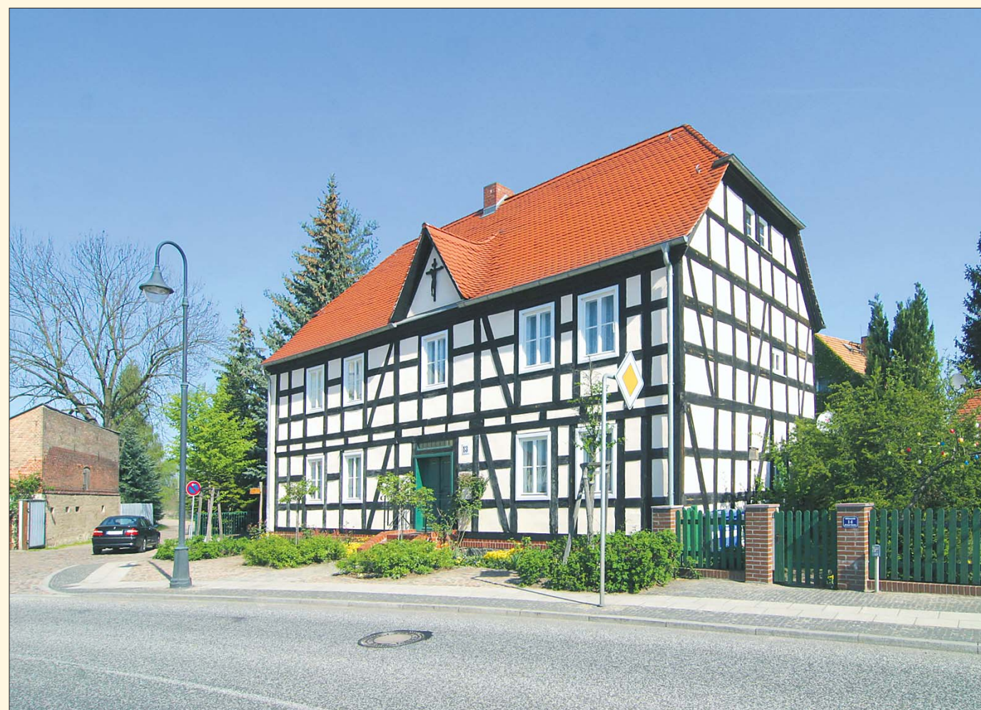
Die erste Erwähnung des „Spittels“ stammt aus dem 16. Jahrhundert. 1997 wurde es saniert und dient heute als Wohnhaus.
