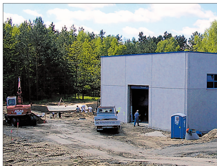
Die Bauarbeiten am Wasserwerk verlaufen planmäßig.
