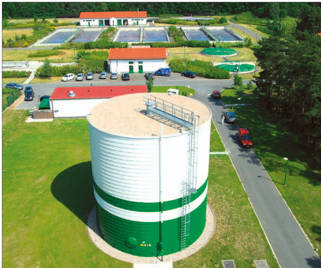
Wasserwirtschaftliche Anlagen – hier der Faulturn vom Nachbarverband in Eisenhüttenstadt – müssen versichert werden.
