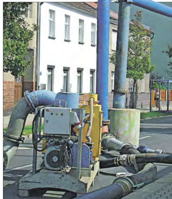
Während der Sanierungsarbeiten in der Kaltenborner Straße ist die Ableitung der Abwässer durch ein oberirdisches Provisorium gewährleistet. Foto: GWAZ
