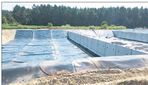
Die Becken werden mit wasserdichter Unterbodenfolie ausgelegt. Die Winkelstützen dienen der Einteilung in drei gesonderte Becken.
