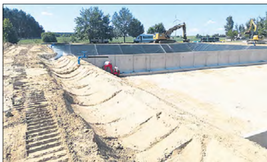
Auf einer Fläche von 50 m x 25 m ist das neue Vererdungsbecken auf der Kläranlage Friedland entstanden.
