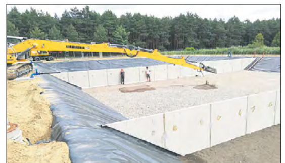
Mit einem Langarmbagger werden die verschiedenen Unterbodenschichten wie Sand und Kies in die Becken eingebracht.
