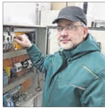
Elektromonteur Heiko Lehmann ist im Bereich Abwasser beschäftigt. Foto: GWAZ/Hoerber
