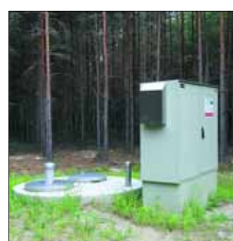
Die Brunnenfassung in Atterwasch.
