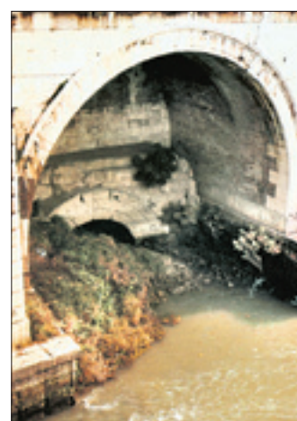
Teile der Abwasserleitung Cloaca Maxima in Rom existieren heute noch.
