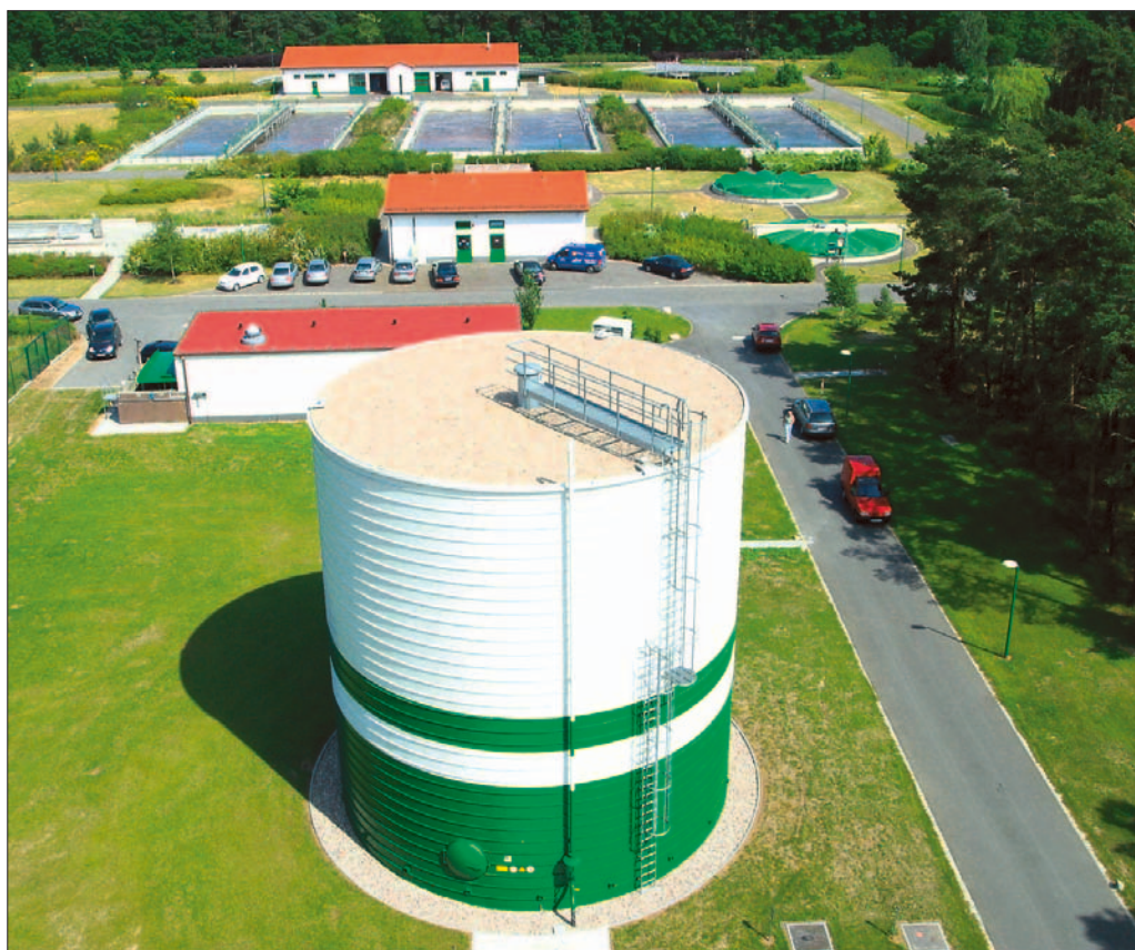
Wasserwirtschaftliche Anlagen – hier der Faulturm vom Nachbarverband in Eisenhüttenstadt – müssen versichert werden.
