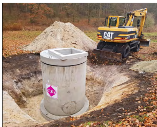
Modern und unterirdisch – der GWAZ hat die Druckerhöhungsstation Kerkwitz umgebaut.
